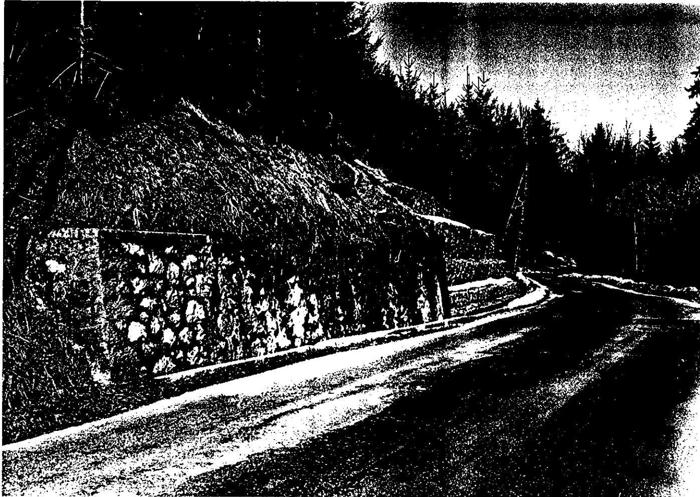
Ouvrages de confortement le long du CD15, en amont des Lignières : gabions, mur en pierres bétonnées. A noter que les terrains continuent à glisser et passent ici, au-dessus des ouvrages.
