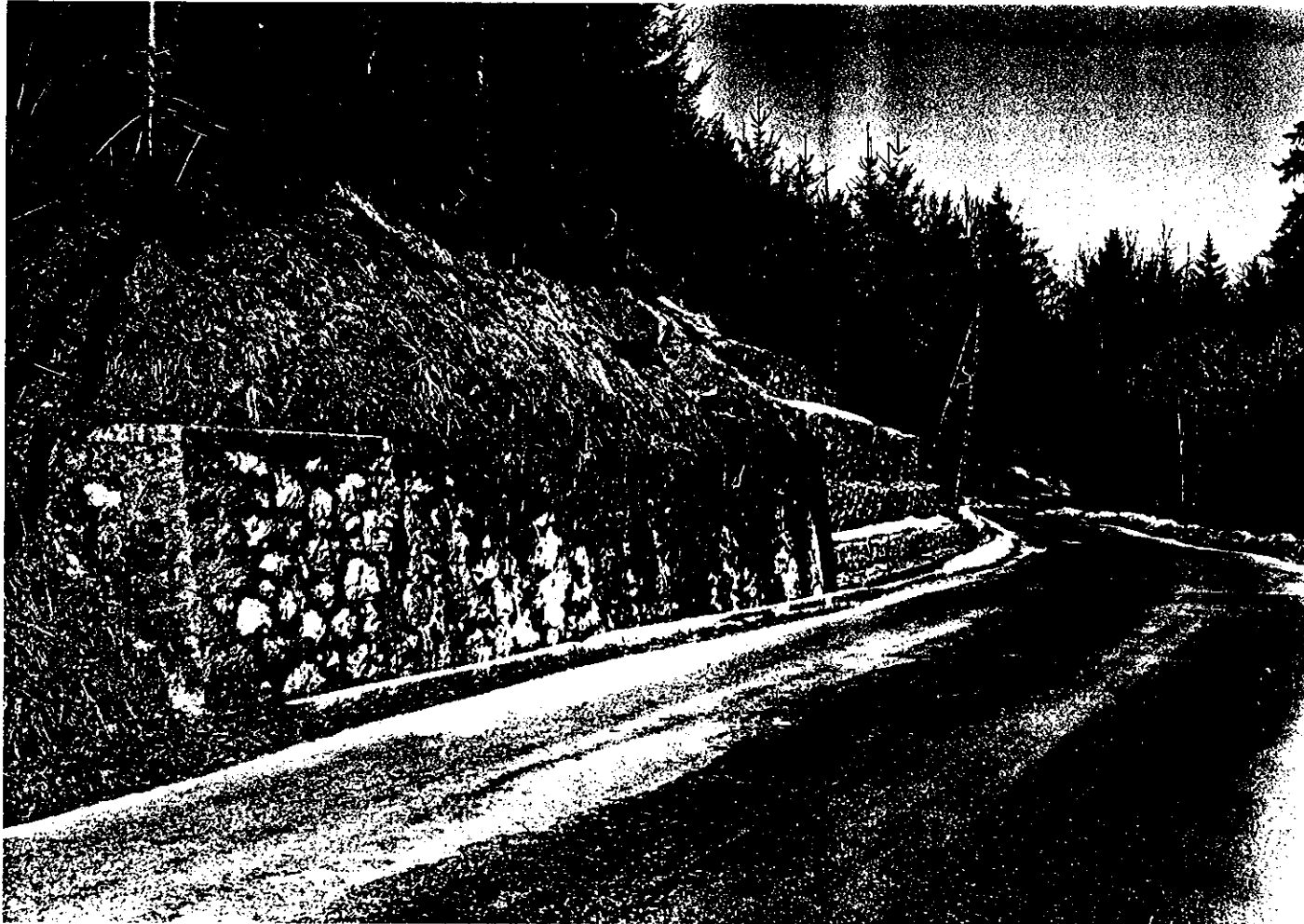
Ouvrages de confortement le long du CD15, en amont des Lignières : gabions, mur en pierres bétonnées. A noter que les terrains continuent à glisser et passent ici, au-dessus des ouvrages.
